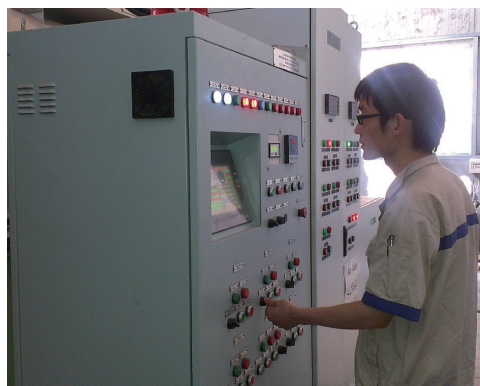
我公司技术人员为巴基斯坦 TBM 柴油电站项目柴油机安保系统产品进行安装调试
